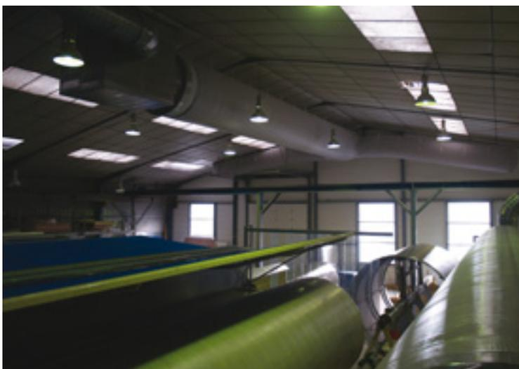
**Photo 5. Gains textiles pour la compensation de l'air extrait**
