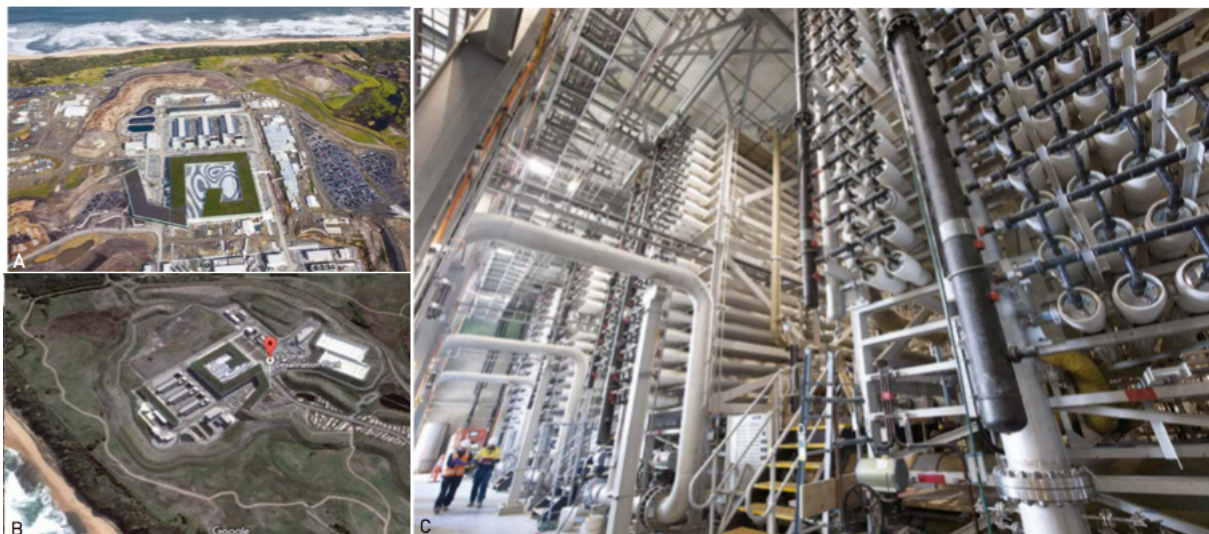
Fig. 3.3 : Usine de dessalement de Melbourne (Australie)
